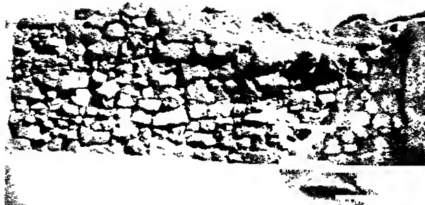
Fig. 75. Vouni. The palace. Wall 183.
